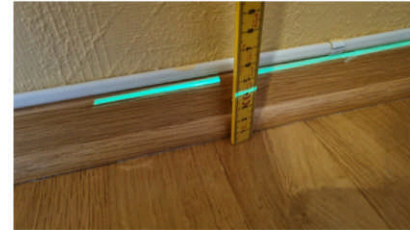
Kontroll av planavvik.
