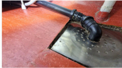
Sluk fra byggeår.
