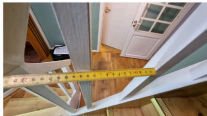
Åpninger i rekkverk er større enn dagens forskriftskrav til rekkverk i trapper (10 cm).
