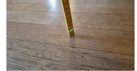
Kontroll av planavvik.
