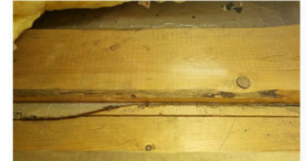
Loftskillet er utført med dampsperre av armert bygningsfolie.
