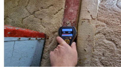
For å forhindre at fukt blir innkapslet, bør gulvet ikke tildekkes med beleg, tepper eller andre materialer som hindrer naturlig uttørking.
