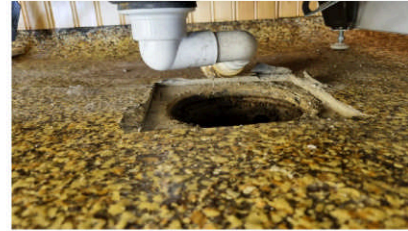
Kontroll av sluk.
