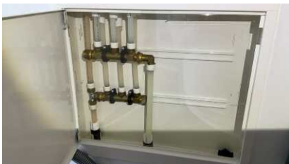
Fordelerskap uten tilgang til stoppekran.
