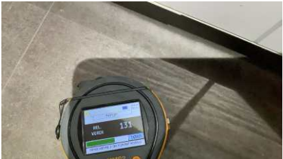
Fuktsøk i våtsone på bad uten å påvise unormale forhold.
