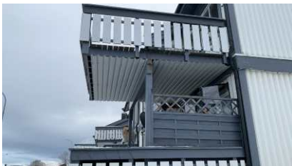
Større avstand på utkraget konstruksjon.
