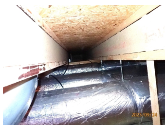
Rantibjelker og taktro av OSB-plater.
