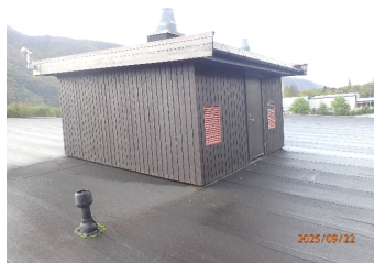
Ventilasjonshus på tak.
