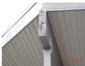
Limtredragere er noe råteangrepet i ender etter fukttrekk.
