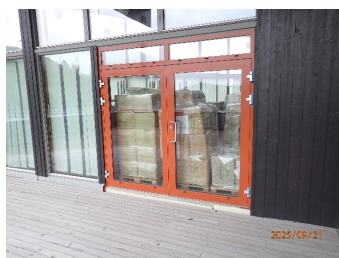
Inngang til veikrodel fra felles terrasse - sørlig side.
