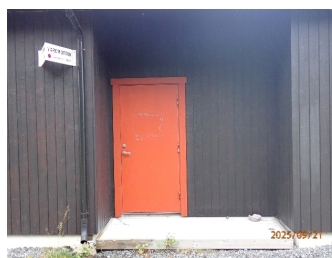
Vareinntak og personalinngang for veikrodel - østre side.
