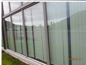
Vinduer av tre med 3-lags glass.
