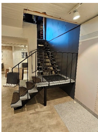
Trapp mellom butikk og utstilling/lager
