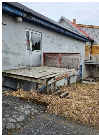
Balkong/rampe i fasade øst
