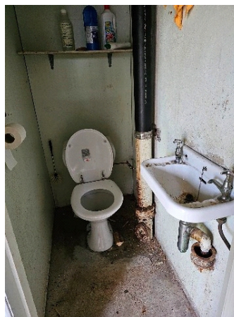
Toalett i eldste del i kjeller, ikke i bruk
