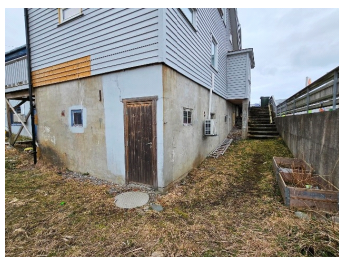
Støttemur mellom kjeller og eiendomen i nord
