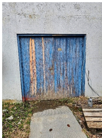
Inngangsdør til utleid verksted i kjeller
