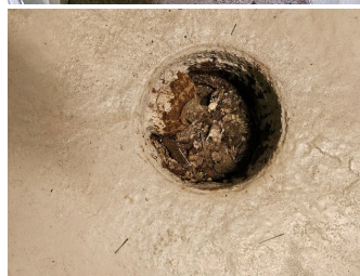
Sluk i kjellergulv i støpejern av eldre opprinnelse
