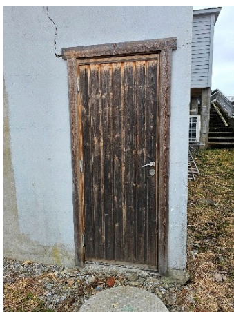
Dør til boder i kjeller
