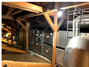
Ventilasjon i loft over tilbygg.
