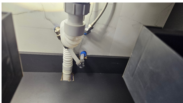
Kontroll av røropplegg.
