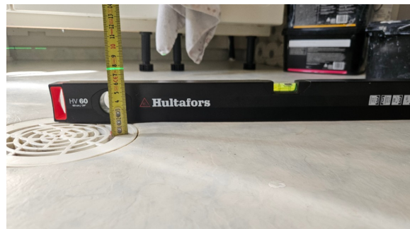
Kontroll av fall mot sluk.
