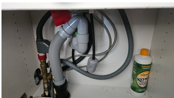
Kontroll av røropplegg.
