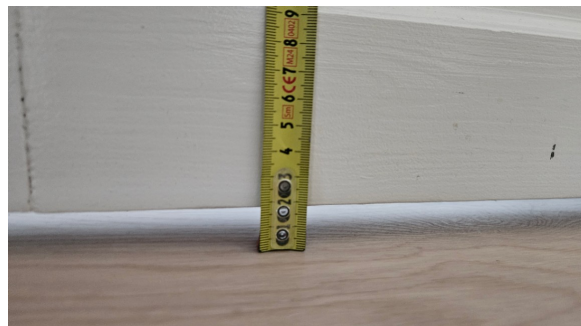
Kontroll av høyde på luftespalte under døren.
