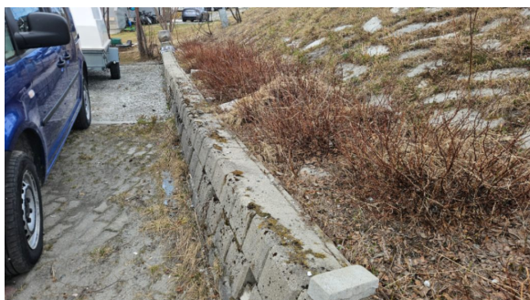
Forstøttingsmur mot vei.
