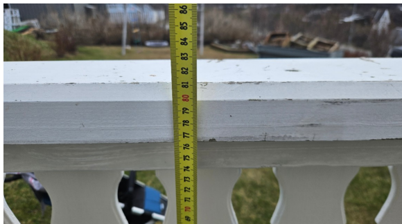
Kontroll av rekkverkshøyde.
