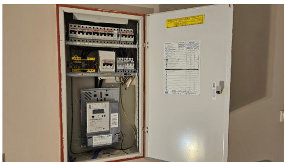
Kontroll av el-skap.
