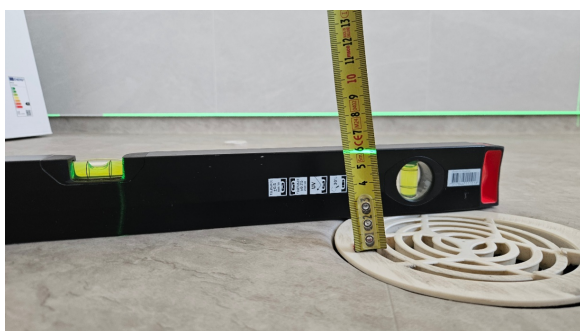
Kontroll av fall mot sluk.
