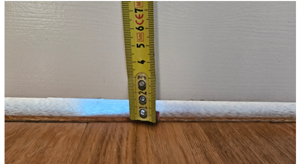
Kontroll av høyde på luftespalte under døren.
