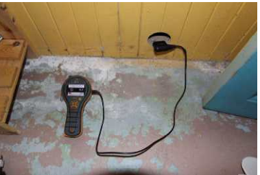
Fuktmåling i kjelleren.
