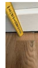
Glipper mellom gulv og listverk
