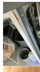
Fuktsvellinger i benkevengen ved oppvaskmaskinen
