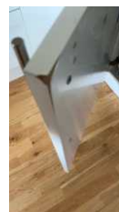
Fuktsvellinger i benkevengen ved oppvaskmaskinen
