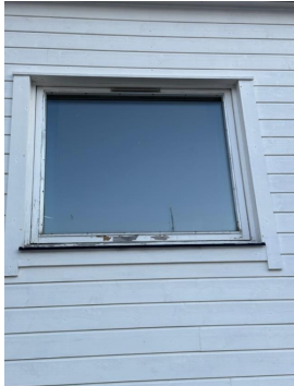
Avflaket maling og påbegynt råteskade.
