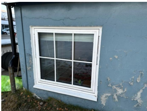
Avflaket maling og påbegynt råteskade.
