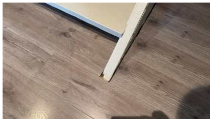
Noe ufagmessig avslutning mot trapp.
