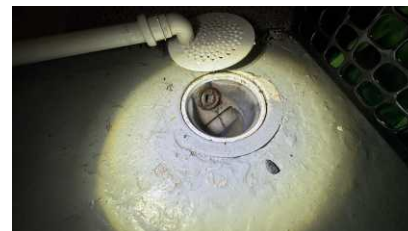
Kontroll av sluk.
