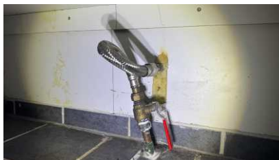
Det er påvist mangelfull/feil utførelse rundt rørgjennomføringer e.l. som gir fare for fukt i konstruksjonen i våtsone.
