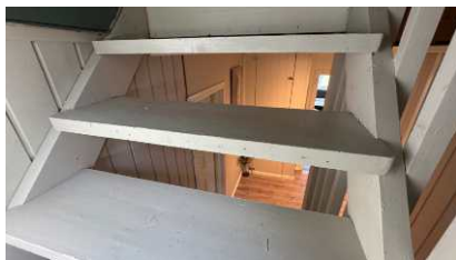
Kontroll av åpninger i opptrinn.
