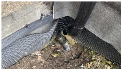
Det er ikke tilfredsstillende bortledning av vann fra taknedløp ved grunnmur.
