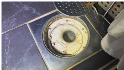
Kontroll av sluk.
