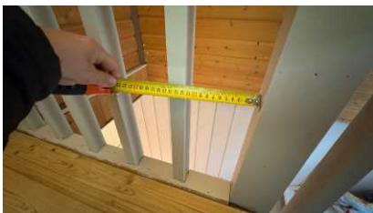
Kontroll av åpninger i rekkverk.
