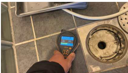
Kontroll av sluk og fuktmåling i dusjsone.
