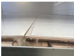
Bilde tatt fra gulv opp langs vegg
