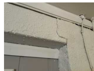
Innvendig vegg underetasje
