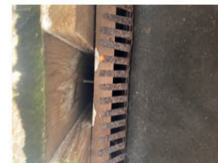
Mangler lusinger mellom kledning
