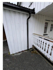
Kort avstand til terreng fra underkant kledning
