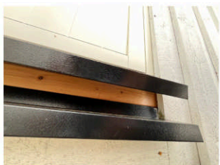
Beslag under dør på loftetasje
