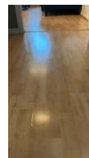
Svelling/ glipper stedvis laminat skjøter
