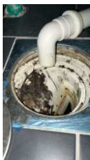
Sluk med ukjent smøremembran
