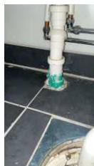
Synlig smør membran rundt rørføringer
