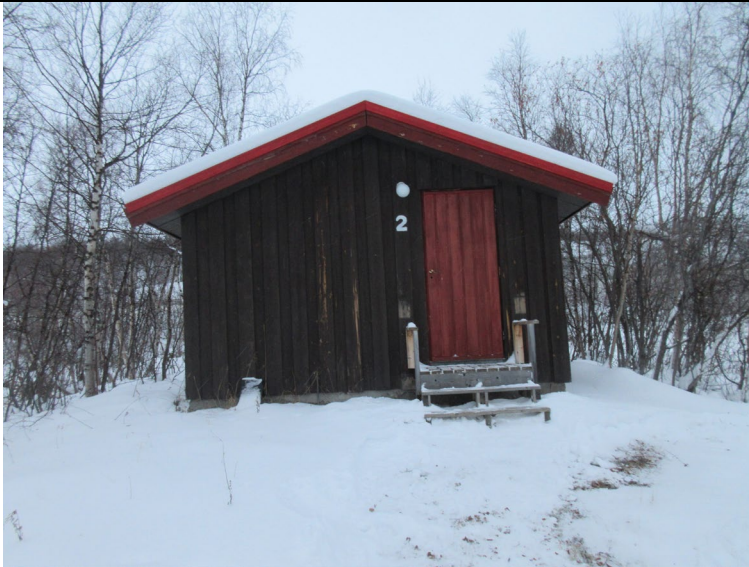
Bilde 18: Fasade storhytte 1 mot sør
