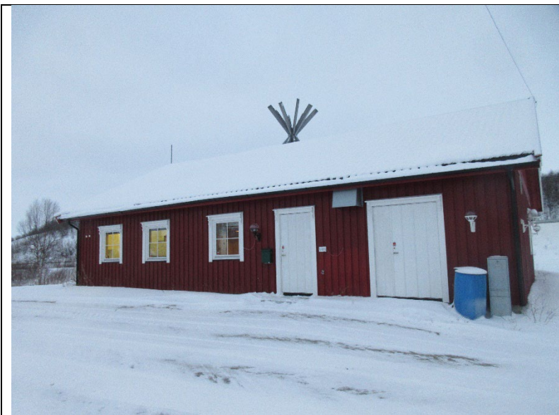
Bilde 2: Fasade øst
