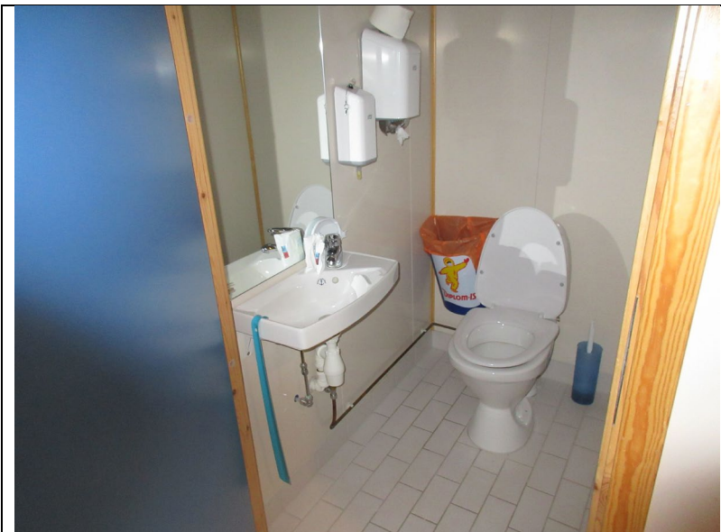
Bilde 11: Toalett med WC og HV.
