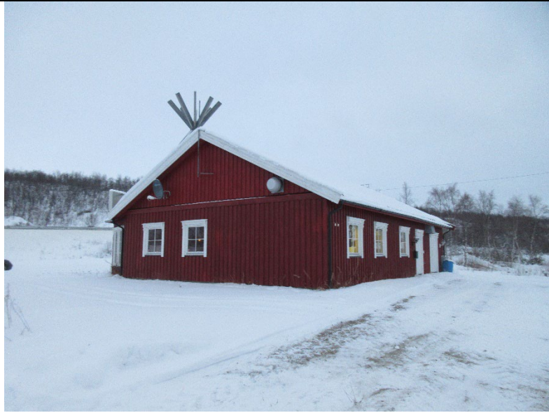
Bilde 3: Fasade nord
