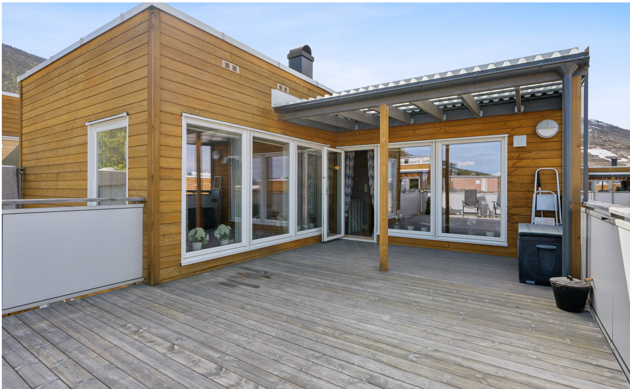
Enderekkehus med oppgradert fasade og en stor terrasse
