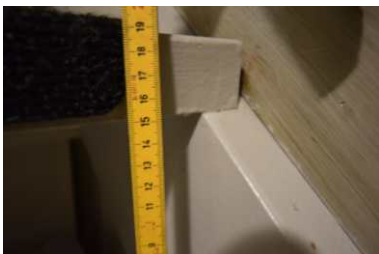
Åpninger mellom opptrinn.
