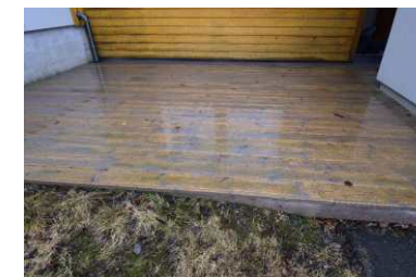
Plating ved inngang
