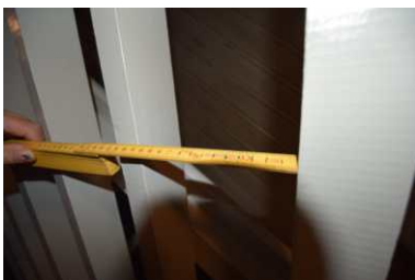
Åpninger i rekkverk.
