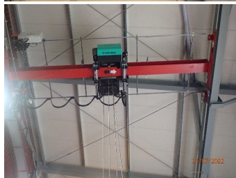
Traverskrane tilbygget del.
