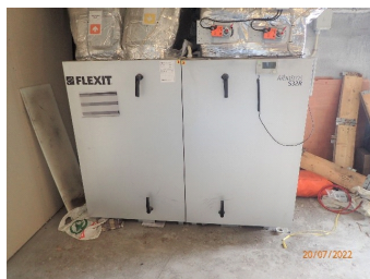
Ventilasjonsaggregat.
