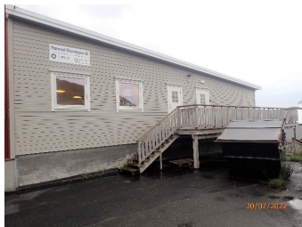
Trapp/terrasse foran inngangsparti.
