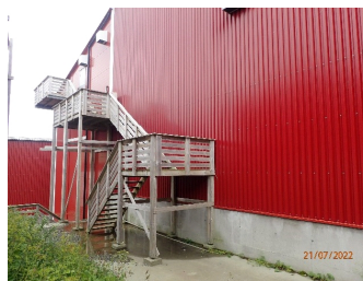
Tretrapp med repos for adkomst mesanin i tilbygget del.
