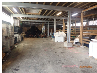
Produksjonshall/lagerhall i 1. etasje.
