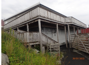
Terrasse og trapp ned til underetasje.
