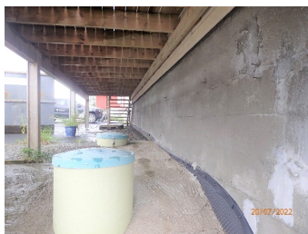
Yttervegg i underetasje mot terreng.
