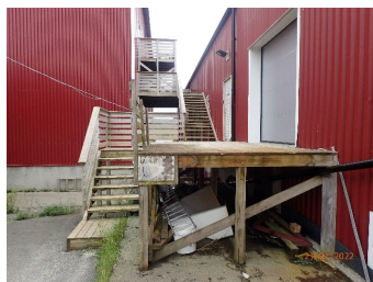
Tretrapp med repos for adkomst 2. etasje.
