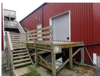
Trapp for adkomst til 2. etasje.
