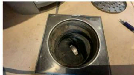
Sluk ETASJE > BAD
