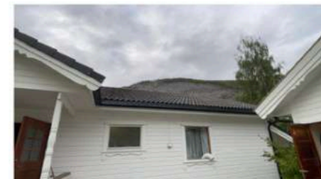
Takplater på tak.
