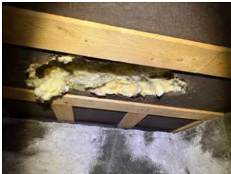
Åpent til gulvkonstruksjon.
