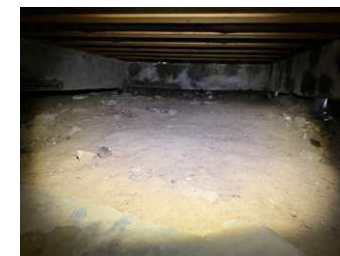
Fuktmåling med pigger i krypkjeller ga ingen forhøyede verdier.
