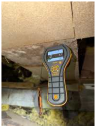
Fuktmåling av gammelt fuktskjold ga ingen påviste fuktverdier.
