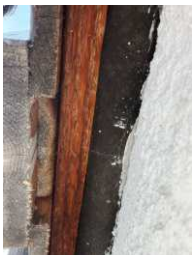
Ingen luftespalte i nedkant av kledning.
