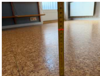
Punktmåling av gulv på loft.
