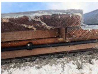
Ingen luftespalte i nedkant av kledning.
