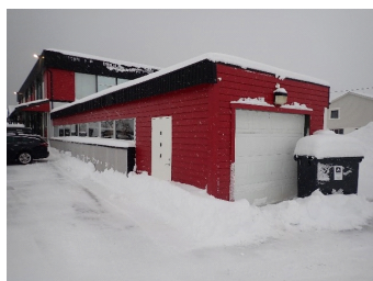
Garasjeport for nedkjøring til kjeller.
