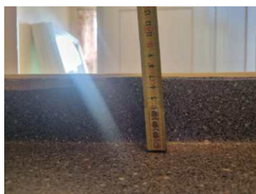
Dør montert opp fra gulv.
