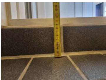
Dør montert opp fra gulv.
