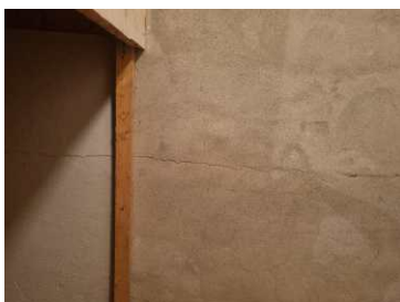
Vertikal sprekk i skillevegg mellom nabohus.
