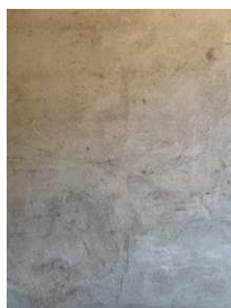
Vertikal sprekk i skillevegg mellom nabohus.
