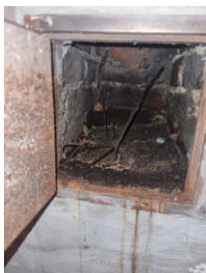
Spor av vann/fukt i sotluke, sotluke anbefales også rengjort.
