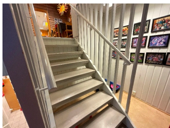
Utsnitt av innvendig trapp.
