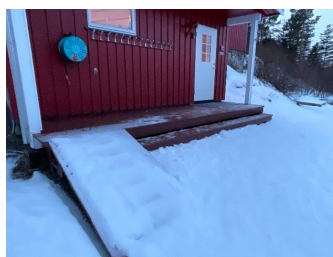
Trapp ved inngang.
