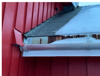
Del av tak med papptekking.
