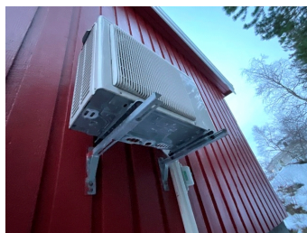
Varmepumpe (luft>luft).
