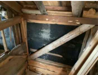
Del av takkonstruksjon
