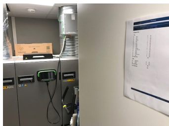
Nytt i tilbygg
