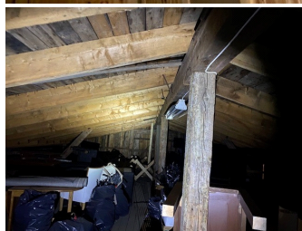
Loftkonstruksjon på utbygg
