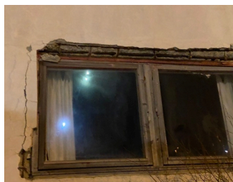
Synlig armeringskorrosjon
