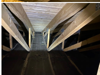
Loftkonstruksjon på utbygg
