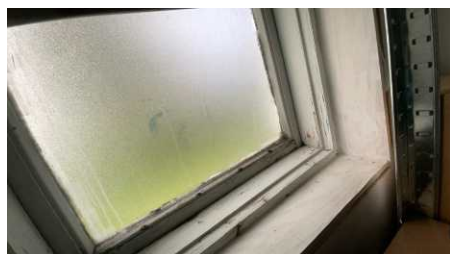
Fuktskade kjellervindu.
