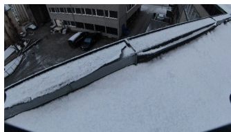
Løsnet plastisolbelegg
