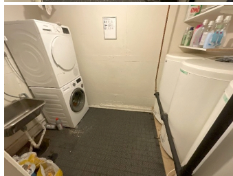
Vaskerom i kjeller
