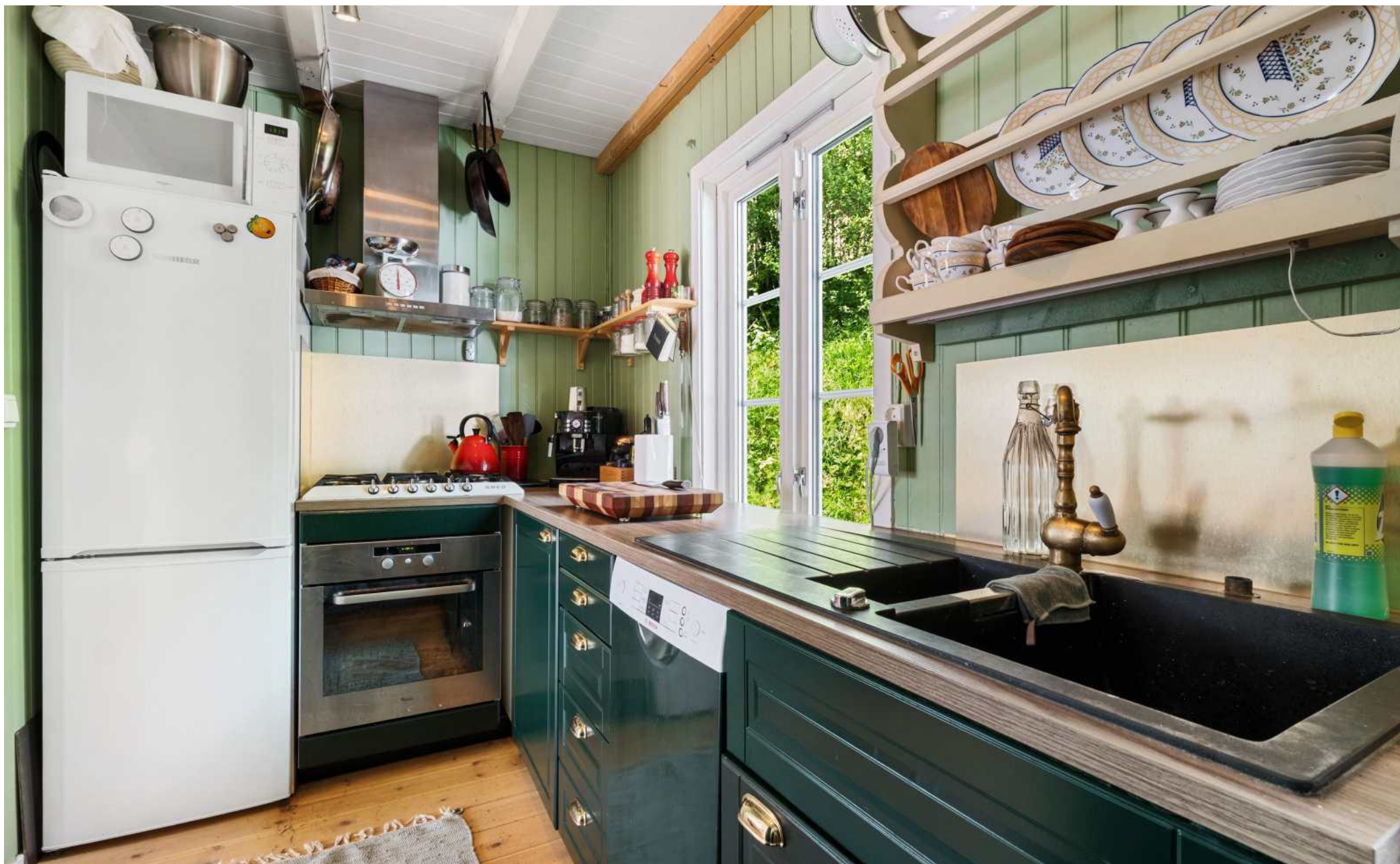
Kjøkkenventilator med avtrekk direkte ut sørger for god utlufting.
