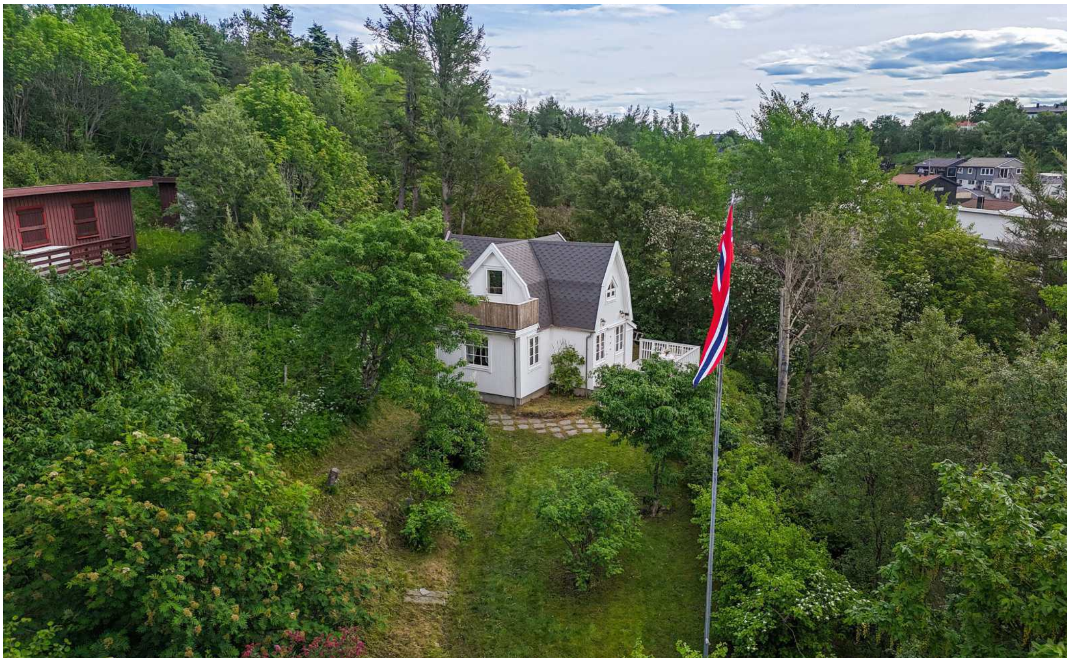
Enebolig fra 1924 med deler av utvendig kledning, samt nye vinduer og dører fra 2011.
