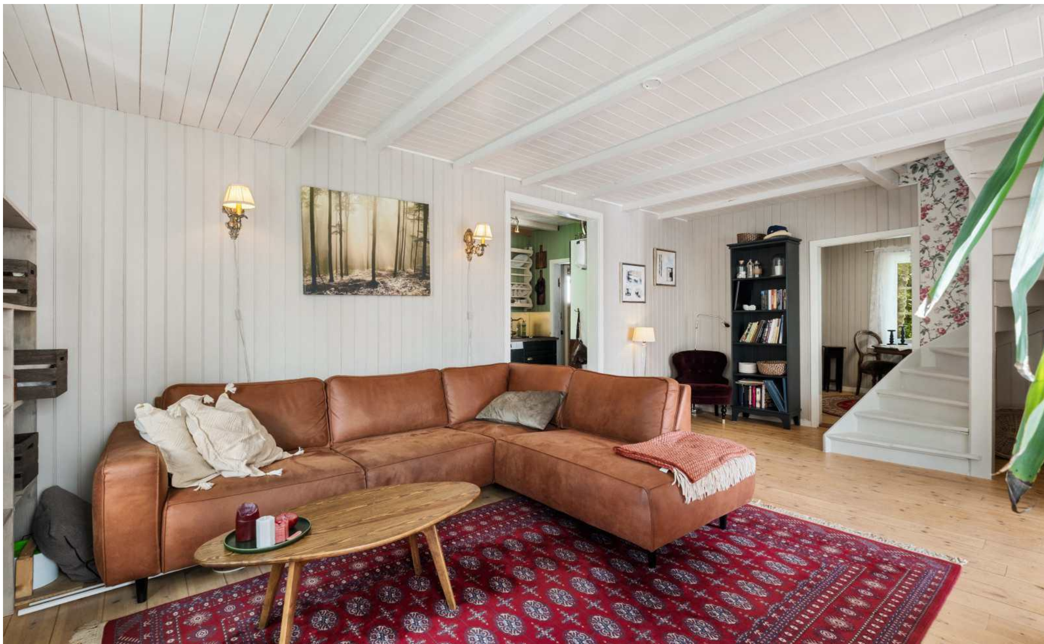
Overflatene i stuen består av trepanel på vegger og i himling.
