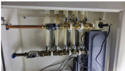
Kontroll av rørfordelerskap.
