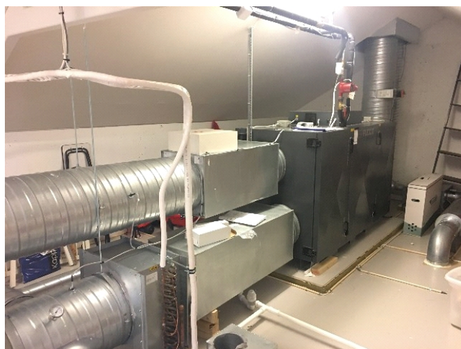
Ventilasjonsaggregat.
