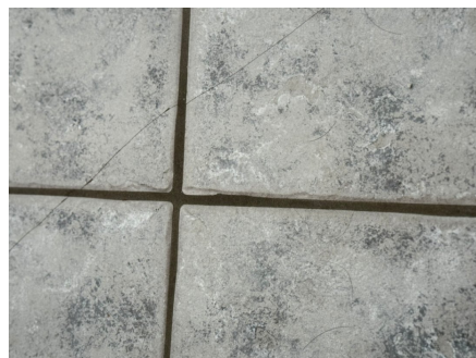
Sprekker og bom under fliser
