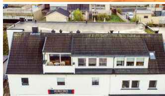
Skrå takdel med takoppløft.
