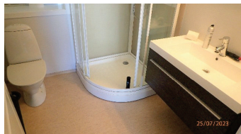
Baderomsinnredning leilighet sørøst:
