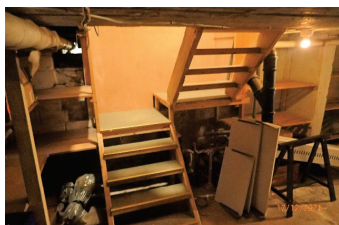
Trapp ned til kjeller.
