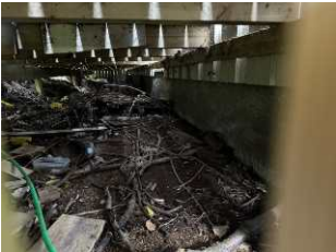
Mot nordøst er grunnmursplast avsluttet under terreng.
