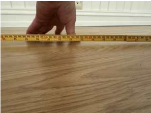
Synlig grop i betonggulv.
