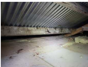
Liten eller ingen lufting ut over raft. Undertak av bølgeblikkplater.
