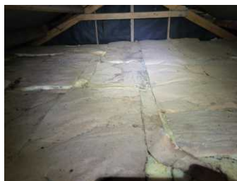
Isolering i loftsillet.
