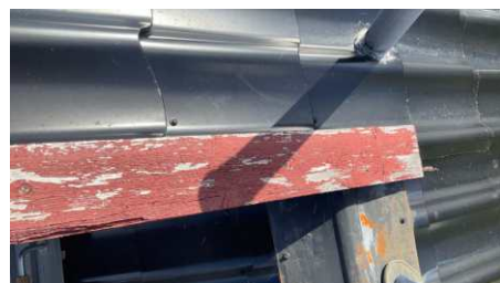
Malingsavflassing på dekkbord
