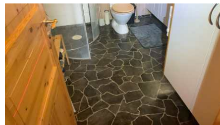
Belegg på gulv.
