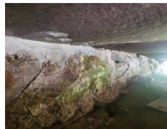
Gråsteinsmur under opprinnelig hytte.
