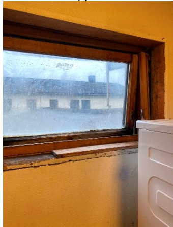
Vindu på vaskerom i nr. 22
