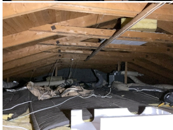
Takkonstruksjon i nr. 18
