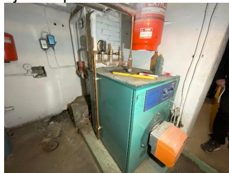
Fyrrom med vannrør som går til ventilasjonsanlegg - ikke i bruk
