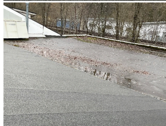
Taktekke over nr. 20 - lager som er tilbygget og har DT elementer
