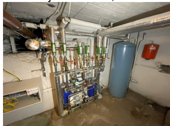
Fyrrom med vannrør som går til ventilasjonsanlegg - ikke i bruk
