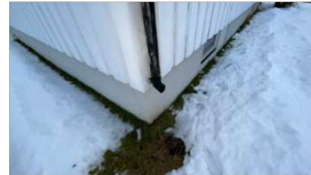
Avslutning av taknedløp ved grunnmur
