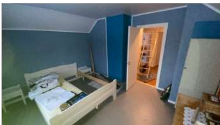
Overflate soverom, 2.etg
