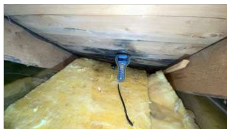
Fuktmåling uten påvist fukt
