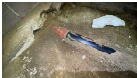
Rørovergang i kjeller mot utvendig avløpsrør
