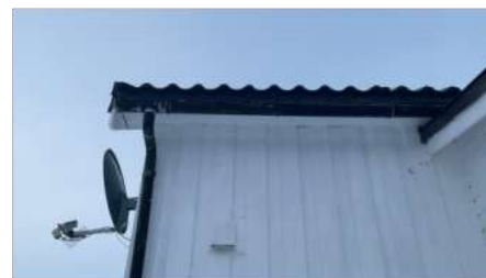
Tette utvendig takkasser
