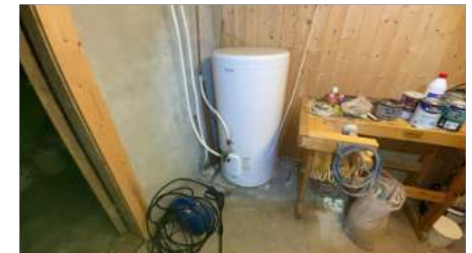
200 lVv-bereder i kjellergang
