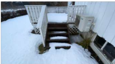
Tretrapp mot balkong
