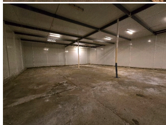
Fryseriet ligger i første byggetrinn. Høyere slitasje, men har god funksjon. Det bør med fordel utføres energieffektiviserende tiltak.
