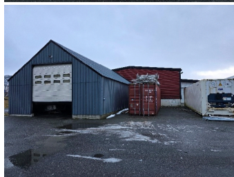
Sørfasade. Kaldtlager fra 2018.
