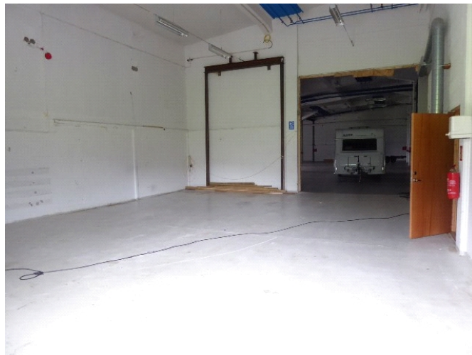
Rom i tilknytning til varemottak og tidligere teknisk lager ( nå bil-/båtlager)
