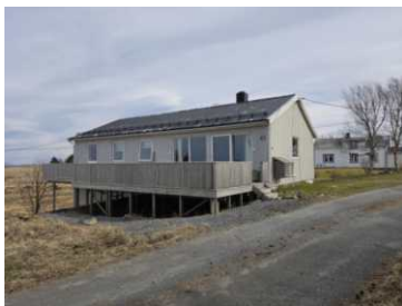
Snøfangere på tak over terrasse
